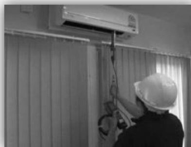
รูปที่ 5.8 การตรวจวัดค่าอุณหภูมิ ความชื้นสัมพัทธ์ ความเร็วลมของเครื่องปรับอากาศ
