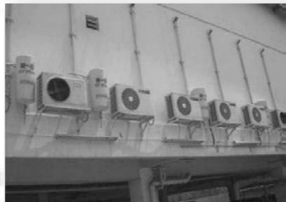
รูปที่ 5.12 การติดตั้งระบบทำน้ำร้อนสำหรับห้องพักร
