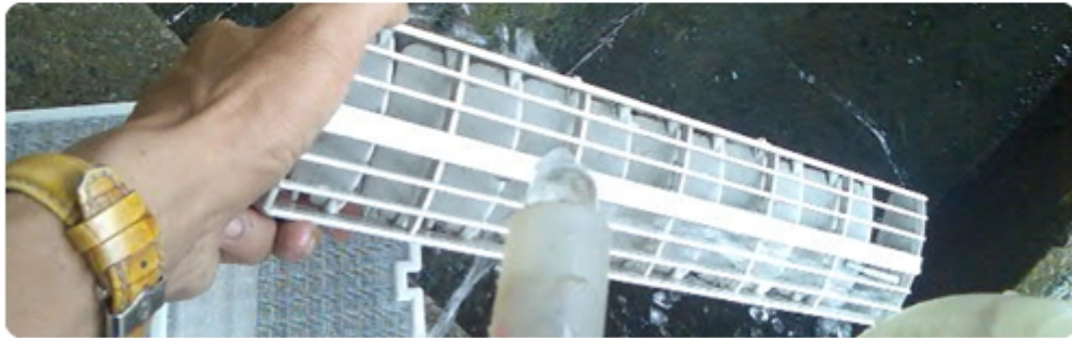
3 ล้างทำความสะอาดหน้ากากเครื่องปรับอากาศ
